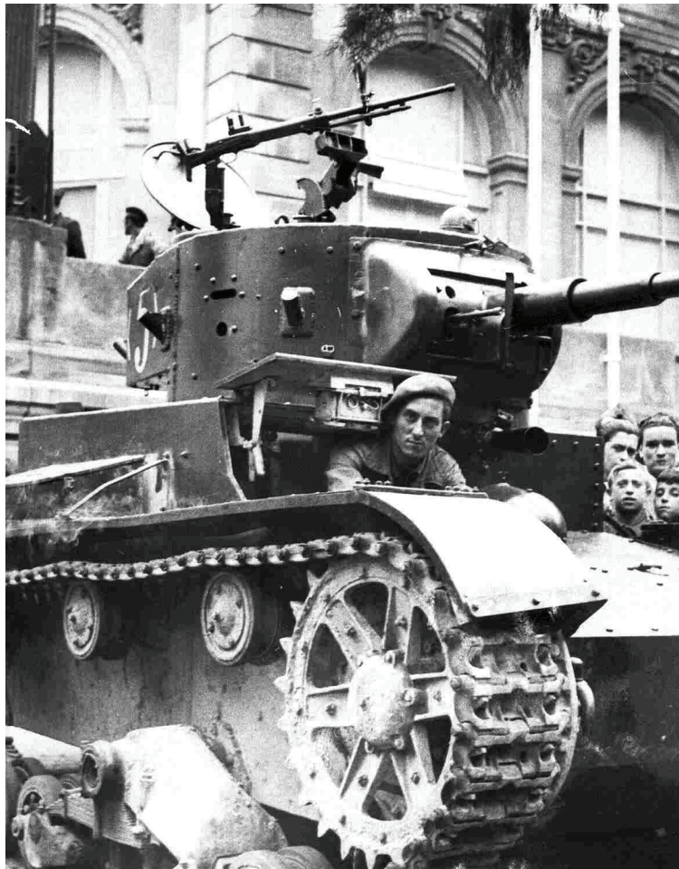
Figura 4: Tanque republicano de fabricación soviética. Los blindados soviéticos eran lentos, pesados, y sólo uno de cada tres estaba equipado con una radio.
